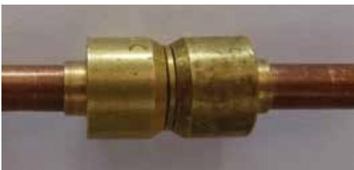
**Imagem 56:** Exemplo de conexão de pressão (união).
