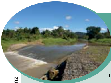
Captação de água no rio Camboriú. Foto: Claudio Klemz
