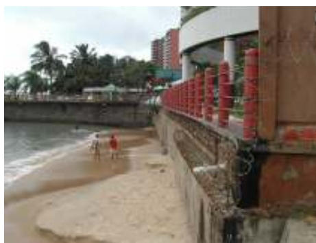
Fotografia 13 - Estreita faixa de praia com a presença de muro de concreto e edificação na faixa de praia. Trecho com déficit de areia e com acesso indireto à zona intermaré. Privatização da orla através da construção de edifícios multifamiliares e hotéis (Fonte, Jeovah Meireles, janeiro de 2005).
