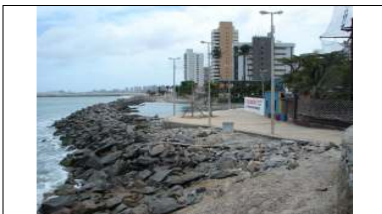
Fotografia 10 - Trecho com obras de engenharia costeira para contenção da erosão ao longo da orla marítima. Verificar a verticalização e o déficit de areia na faixa de praia (Fonte: Projeto Orla, outubro de 2005).
