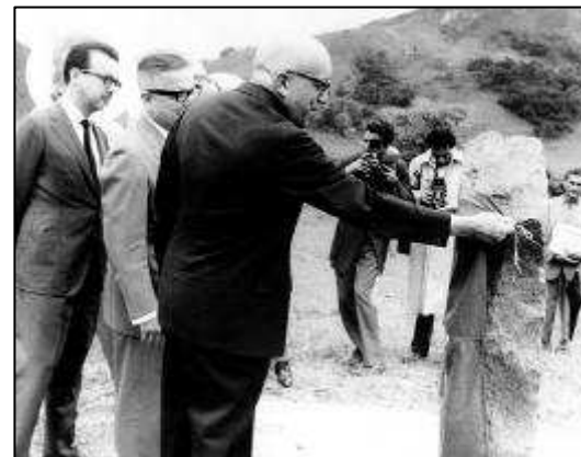
Início das obras - 1962
