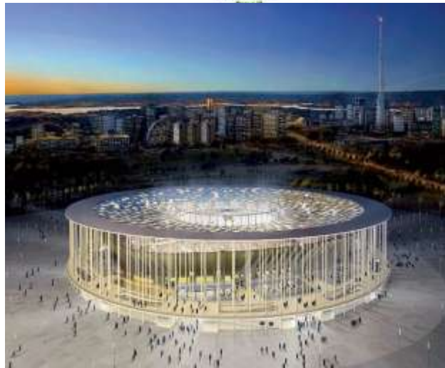
Estádio Nacional de Brasília – DF LEED NC v.3 - Out/09
