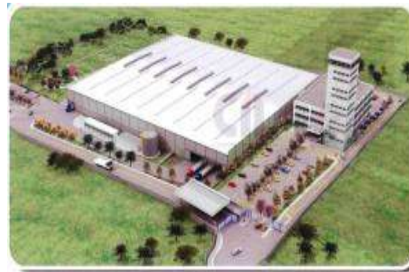
Fabrica Otis Elevadores SBCampo - SP
