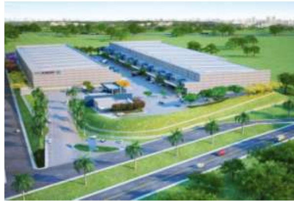
Galpão Industrial GR Properties Jundiai - SP
