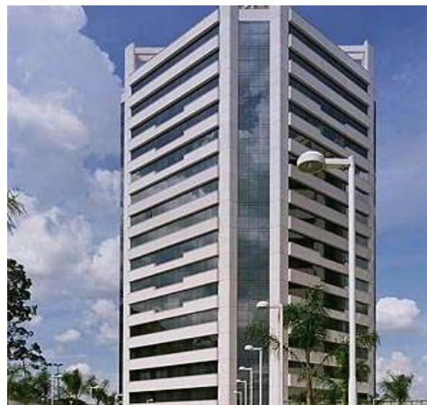
CE Rio Negro Edifício Demini Alphaville - Barueri/SP LEED EB_OM Certificado Silver– Ago.11
