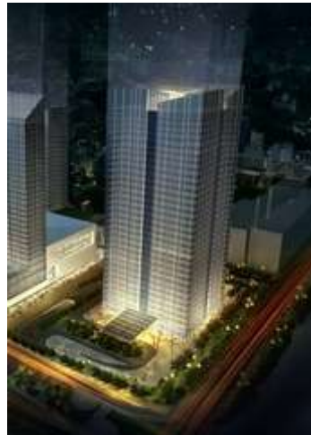
WTorre JK – Torre Santander São Paulo/SP LEED CS 2.0 Gold – Dezembro/2010
