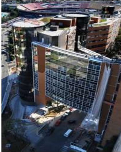
Hosp. Albert Einstein Morumbi São Paulo/SP LEED NC2.2 Gold - Agosto/2010
